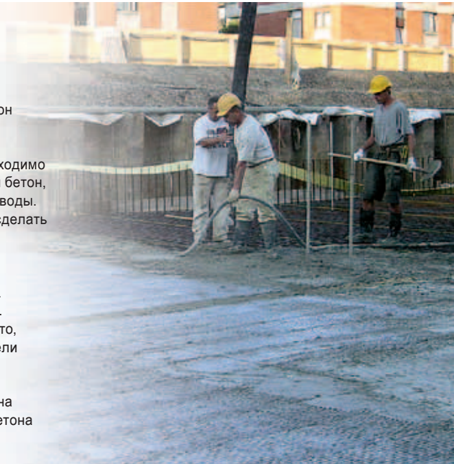
Бетонирование фундамента с применением водонепроницаемого бетона.
